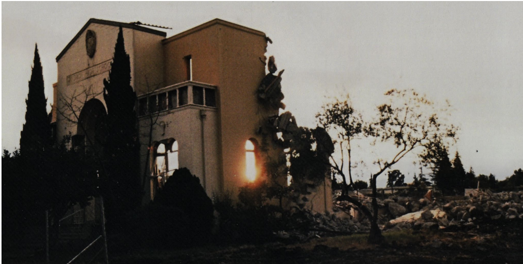
Demolición de la escuela secundaria Mountain View, 1987
